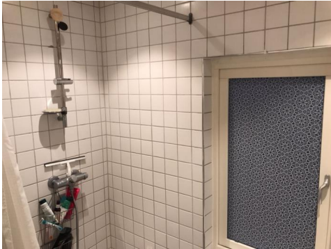
Bildet viser vindu i våtsone.
